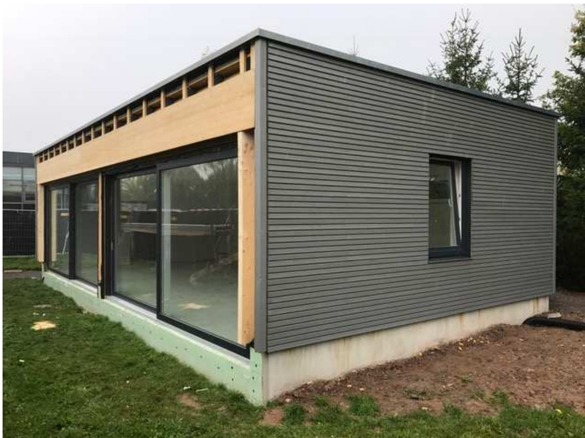
Baufortschritt des neuen Ruheraumes
